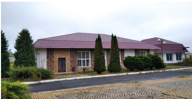
Столовая на 50 мест с оборудованием
